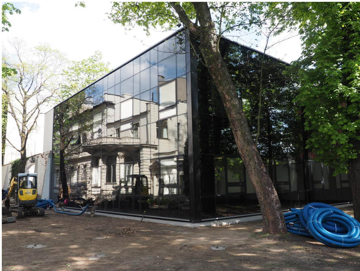
Budynek J po przebudowie, maj 2018
