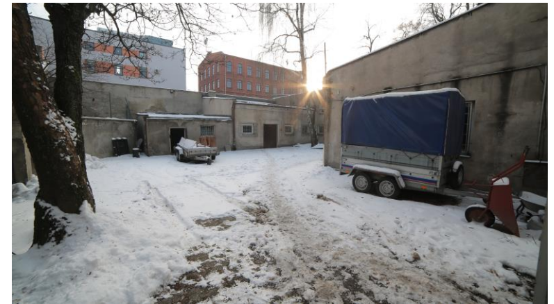
Budynek J przed rozpoczęciem prac renowacyjnych, styczeń 2017
