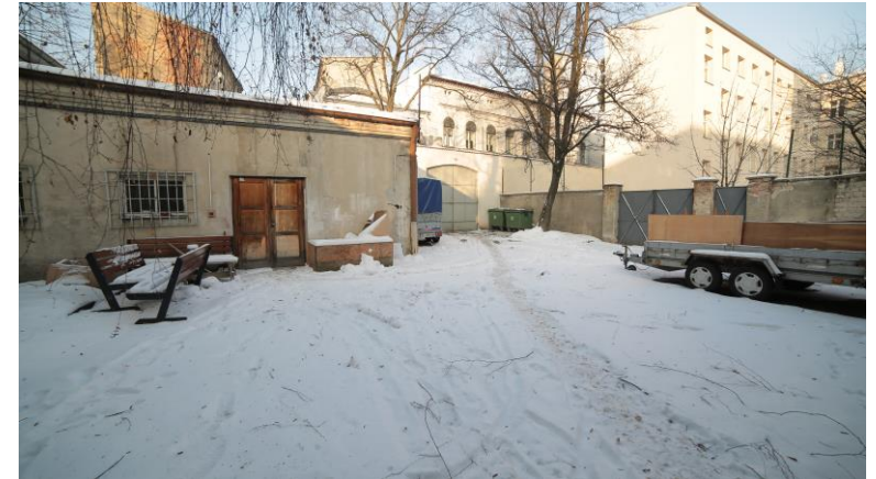
Budynek J przed rozpoczęciem prac renowacyjnych, styczeń 2017
