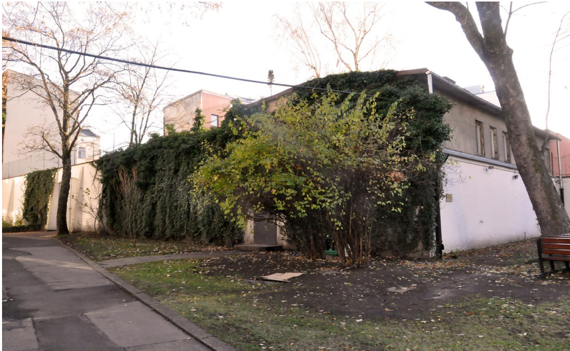
Budynek J przed rozpoczęciem prac renowacyjnych, listopad 2016
